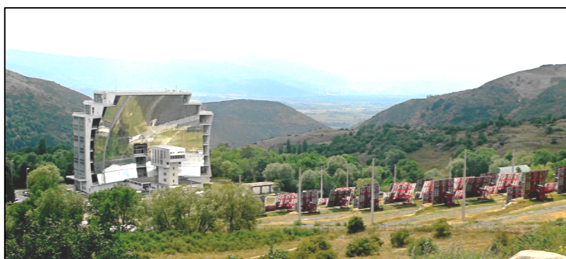
Le grand four solaire d'Odeillo dans le sud de la France (Pyrénées-Orientales). Des miroirs orientables situés à flanc de montagne, dirigent les rayons du Soleil vers d'autres miroirs disposés en paraboloïde.
